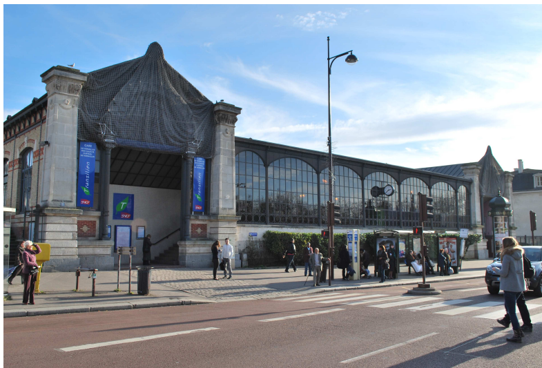
La façade extérieure de la gare, avec ses deux tympans voilés de filets
